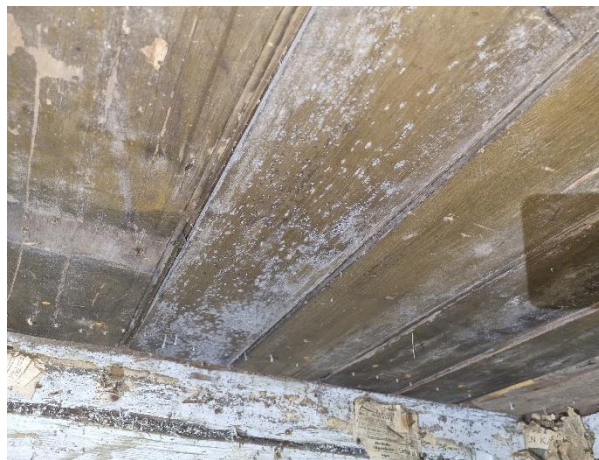
Foto 22. Mikrobiell påväxt på takbjälkar/innertak.
