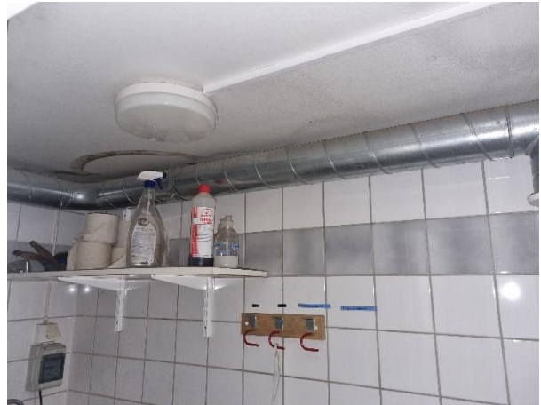
Foto 8. Mikrobiell påväxt på innertak samt fuktrosor från inläckage.
