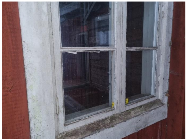
Foto 6. 2 glas fönster med underhållsbehov. Kitt släpper.
