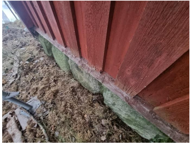
Foto 4. Torrsprickor och rötskador på panel vid nederkant.
