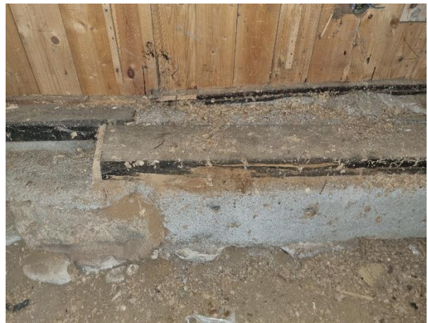
Foto 12. Behandlade syllar där rötskador och insektsangrepp noteras.
