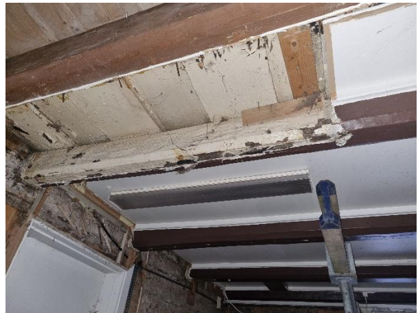
Foto 14. Innertak där färgsläpp noteras.
