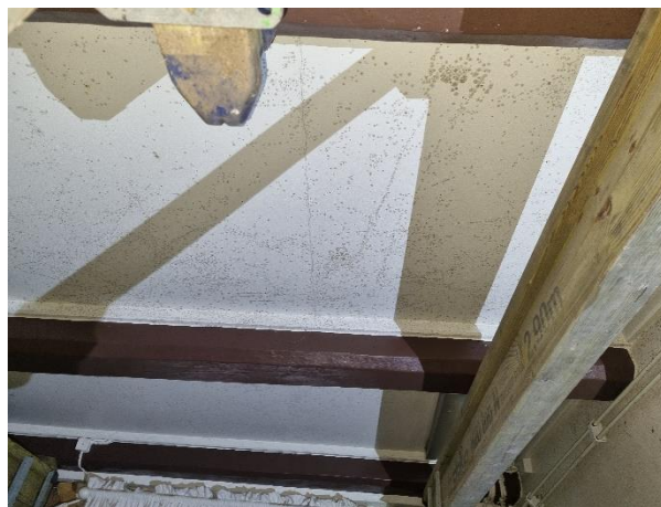
Foto 24. Mikrobiell påväxt på takbjälkar/innertak.
