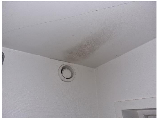
Foto 10. Smuts/mikrobiell påväxt på innertak vid frånluftsdon.
