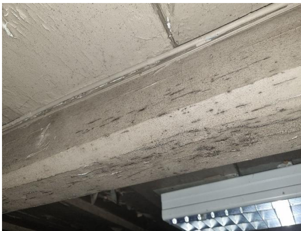
Foto 21. Mikrobiell påväxt på takbjälkar/innertak.
