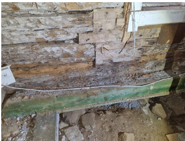
Foto 23. Rötskador i nederkant vägg. Grön träbjälke har begjuttits i efterhand mot timmer.
