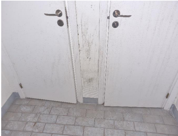
Foto 7. Bedömd mikrobiell påväxt på dörrar och innerväggar.
