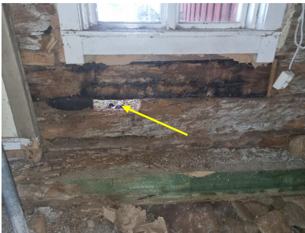
Foto 19. Stora rötskador med angrepp från äkta hussvamp i yttervägg. Hål till utsida (se pil). Foto taget i rum 2.
