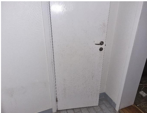
Foto 9. Mikrobiell påväxt på innerdörr.
