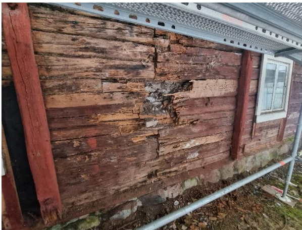
Foto 5. Rötskador på bakomliggande timmer. Förstärkningsbjälkar syns även på bilden. Förstärkningsbjälkarna finns däremot runt hela huset.
